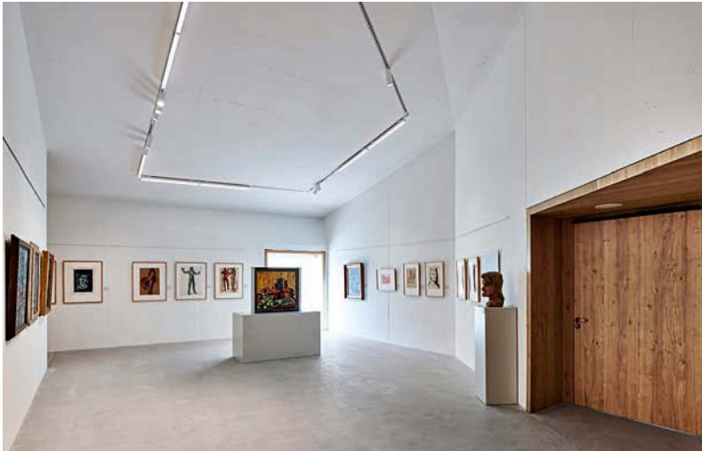
Lichtschienen sind in die Betondecken ... • Light tracks are embedded in the concrete ceilings ...
